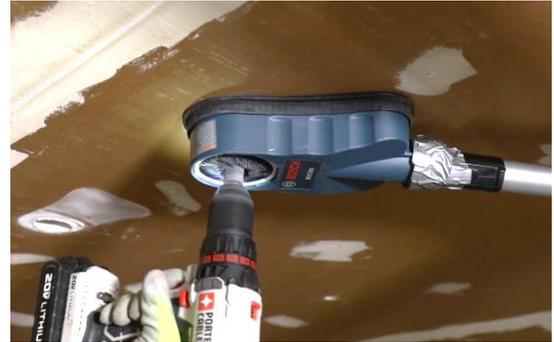
**Perforación con uso seguro del plomo:** el uso de un taladro con cubierta y una aspiradora con filtro HEPA elimina el polvo donde se genera.
