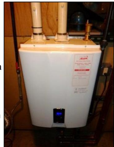
En una caldera de alta eficiencia, el agua de retorno actúa como refrigerante de los gases de escape. Cuanto más baja sea la temperatura del agua de retorno, más se enfriarán los gases de escape, lo que, a su vez, aumenta la cantidad de agua que se condensa en el escape y así, la eficiencia de la caldera. Por este motivo, las temperaturas más bajas del agua de retorno se correlacionan con el aumento de la eficiencia.
