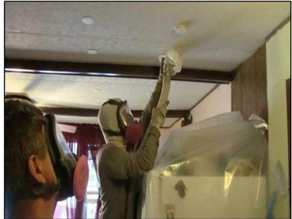
**Instalación del aislante a través del cielo raso:** el técnico introduce a presión el tubo de llenado en la cavidad y lo saca cerca del borde del techo. Los agujeros se perforan en línea recta por cuestiones estéticas.
