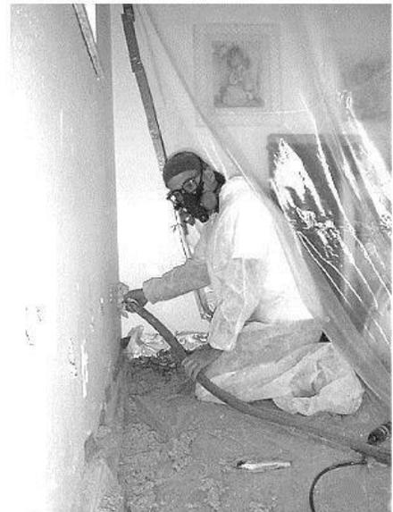
**Carpa de insuflación de paredes:** esta carpa protege al cliente y a sus pertenencias del aislante y el polvo de la pintura.
