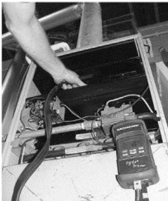
**Comprobación de unidades de calefacción central antiguas:** inserte la sonda en el desviador de tiro cerca de los puertos de escape del intercambiador de calor.
