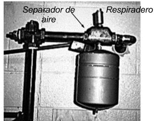
**Tanque de expansión, separador de aire y respiradero:** la prevención de la presión excesiva y la eliminación del aire de los sistemas son importantes para los sistemas de distribución hidrónicos.
