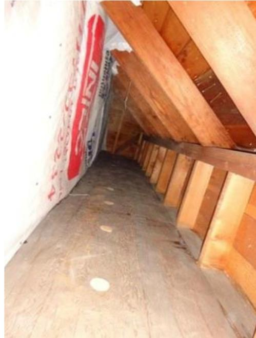
6. Al aislar las paredes de buhardilla con aislamiento de lana de fibra de vidrio, utilice lanas del tamaño adecuado para que encajen en las cavidades de los montantes.
