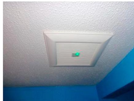
**Extractor de aire montado en la superficie:** los extractores de aire ayudan a la calidad del aire al introducir aire fresco en el edificio mientras eliminan los contaminantes del interior.
