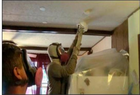
**Instalación del aislante a través del cielo raso:** el técnico introduce a presión el tubo de llenado en la cavidad y lo saca cerca del borde del techo. Los agujeros se perforan en línea recta por cuestiones estéticas.
