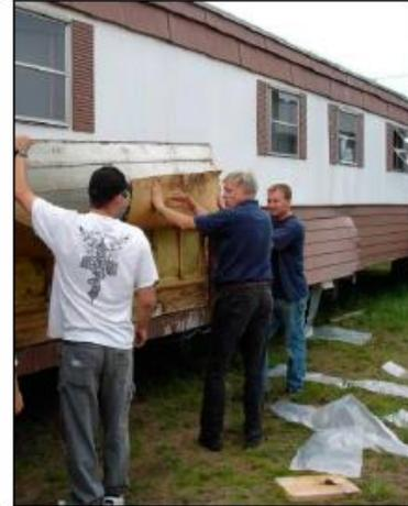
**Aflojamiento del revestimiento para el aislamiento de paredes:** retire los tornillos de la parte inferior del revestimiento metálico. Antes de instalar el aislante, fije las láminas de revestimiento a la parte inferior con un tornillo corto de chapa.
