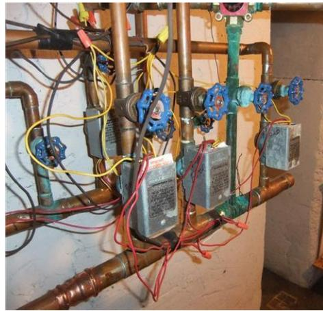
**Válvulas de zona:** un termostato independiente controla cada válvula de zona. Cuando un termostato requiere calor, la caldera se activa y la válvula de zona se abre.
