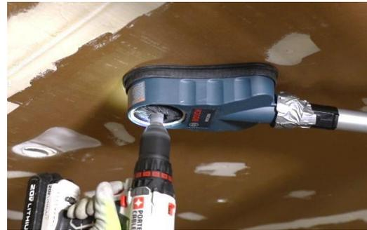
**Perforación con uso seguro del plomo:** el uso de un taladro con cubierta y una aspiradora con filtro HEPA elimina el polvo donde se genera.
