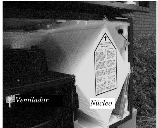
**Núcleo del HRV de polietileno:** este intercambiador de calor de contraflujo con placas planas se desliza para quitarlo para su limpieza.
