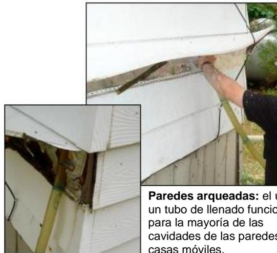
**Paredes arqueadas:** el uso de un tubo de llenado funciona bien para la mayoría de las cavidades de las paredes de las casas móviles.
