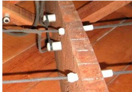
**Cableado de la perilla y el tubo:** antes de aislar alrededor del cableado de la perilla y el tubo, se deben instalar barreras para mantener el aislante a un mínimo de 3 pulgadas de los cables.
