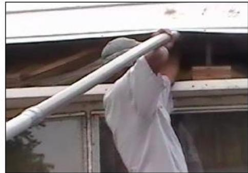
**Insuflado del borde del techo:** utilice un tubo de llenado rígido para insuflar el aislante a través del borde del techo. Esto evita realizar agujeros en el techo, aunque este proceso requiere de mucho cuidado al volver a fijar y sellar el borde del techo.
