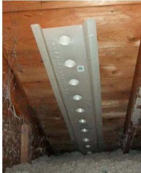
**Canaleta del plafón:** permite la instalación de la máxima cantidad de aislante en esta área fría. También evita que el viento quite el aislante y que se obstruyan las vías de aire por el aislamiento insuflado.
