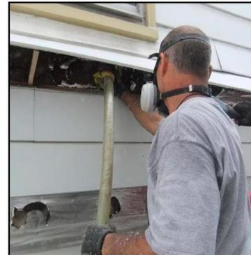
**Llenado de paredes mediante tubos:** el aislante se insufla de manera compactada en las paredes mediante el uso de un tubo de llenado que se inserta en la cavidad de la pared.
