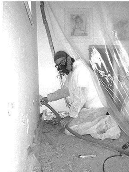
**Carpa de insuflación de paredes:** esta carpa protege al cliente y a sus pertenencias del aislante y el polvo de la pintura.
