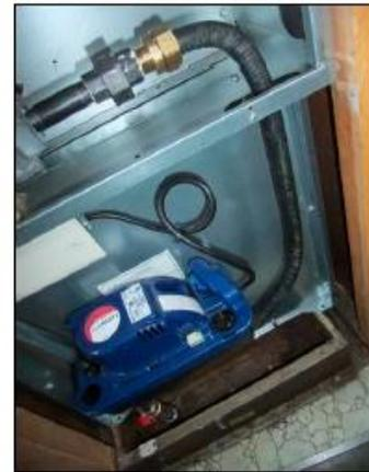
**Bombas de condensación:** estas pequeñas bombas se instalan en el gabinete de la unidad de calefacción central.
