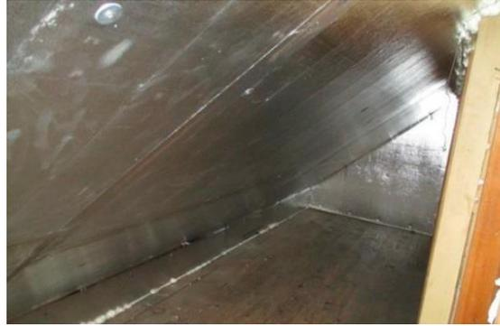
Método B, utilizando una placa de espuma de poliisocianurato con sus caras recubiertas con láminas de aluminio como barrera de vapor y de aire.
