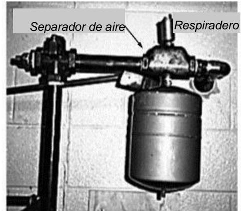
**Tanque de expansión, separador de aire y respiradero:** la prevención de la presión excesiva y la eliminación del aire de los sistemas son importantes para los sistemas de distribución hidrónicos.
