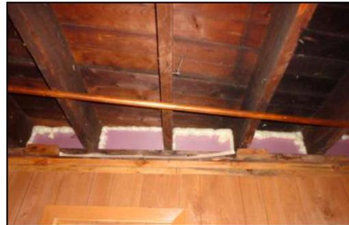
**Aislamiento y sellado de aire en la vigueta de borde:** aislante de placas rígidas instalado en las cavidades de las viguetas, con espuma en aerosol para sellar en los bordes.
